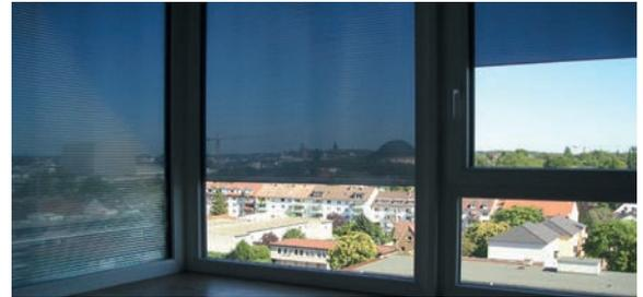
Der Gesamtenergiedurchlassgrad der Verglasung einschließlich Sonnenschutz  $g_{tot}$  kann vereinfacht nach Gleichung berechnet werden. Alternativ kann das Berechnungsverfahren für  $g_{tot}$  nach DIN V 4108-6, Anhang B verwendet werden.
