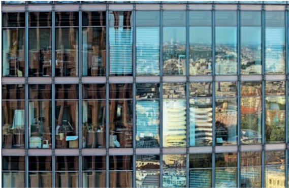
Transporte in andere geodätische Höhenlagen sowie Temperaturänderungen lassen die Außenseiten aus- oder einbauchen. So entstehen trotz absolut ebener Einzelscheiben unvermeidlich verzerrte Spiegelbilder.
