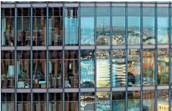
Abb. 3.31: Isolierglas-Effekt
