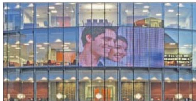
Innovation aus Verden: ein großes, in die Fassadenverglasung integriertes Display. • Foto: Frerichs
