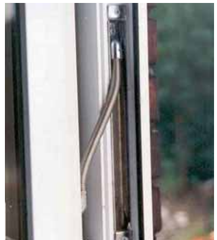
Abb. 41: Kabelführung
